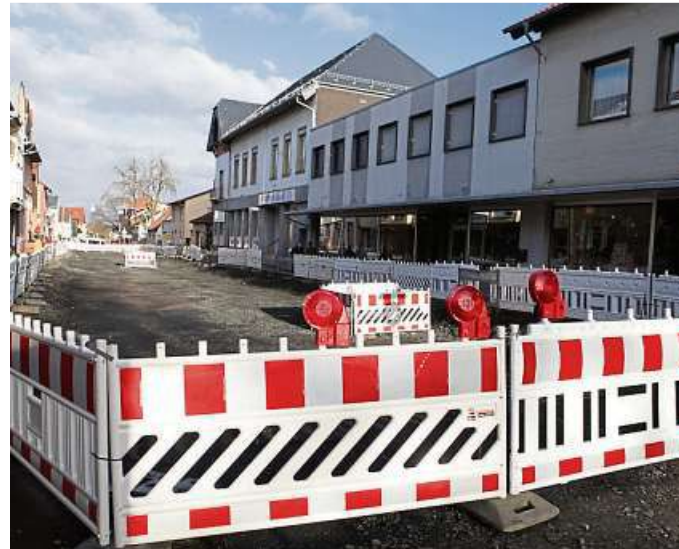
Die Arbeiten beim zweiten Bauabschnitt der Friedrich-Ebert-Straße liegen zeitlich im Plan. Archivfoto: pakalski-press/Axel Schmitz
